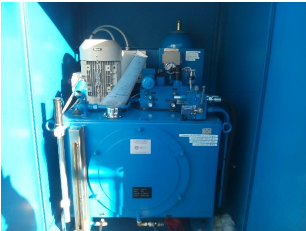
Motor črpalke za mazanje reduktorja
